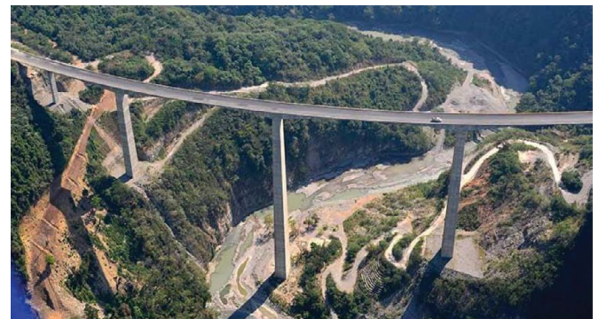
Figure 1: Highway Nuevo Necaxa-Avila Camacho.
