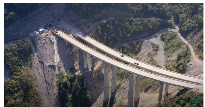
Figure 2: Highway Nuevo Necaxa-Avila Camacho.
